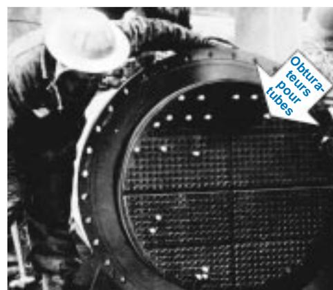
Obturbateurs enfoncés dans les tubes qui fuient juste avant la remise en service de l'échangeur de chaleur.
