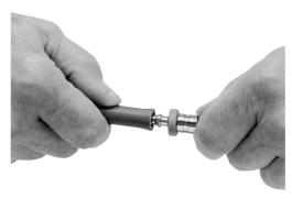
3. Positionner la connexion sur une surface plane. Agripper le flexible et inserer la connection jusqu'à l'epaulement sous le capuchon bleu.
