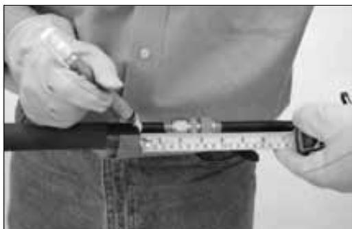
3. Длина термоусадочных муфт составляет 125 мм (5 дюймов). Отметьте трубку так, чтобы расположить муфту по центру над фитингом. Муфта должна заходить на оболочку трубки не менее, чем на 25 мм (1 дюйм).
