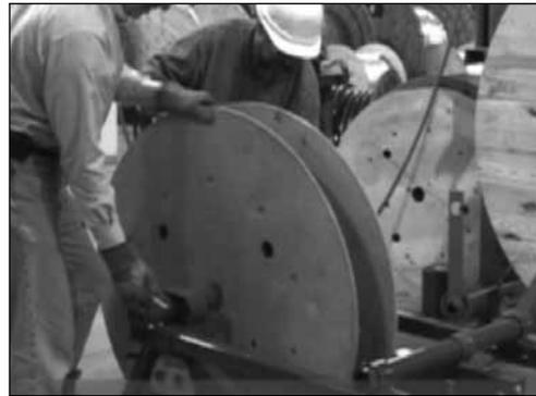
1. С помощью ската поднимите катушку на место.
