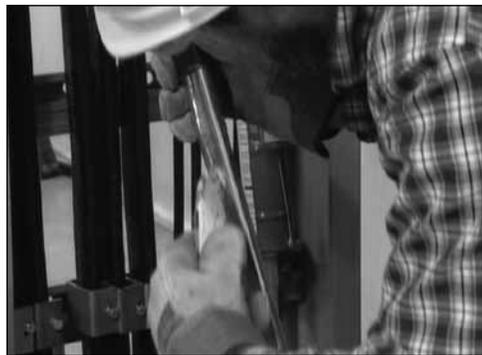
4. Отрежьте и снимите обмотку из полиэстера.
