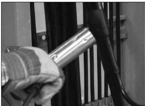
9. С помощью промышленного фена усадите муфту на трубке. Перемещайте источник тепла туда и обратно над муфтой, подавая тепло равномерно.
