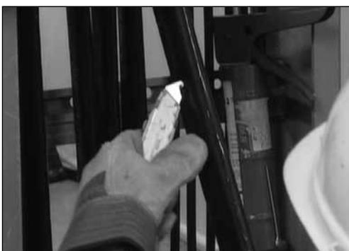
2. Разрежьте наружную оболочку по оси и снимите ее.
