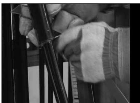
5. Разрубите алюминиевую укрепляющую пластину ножом и отломайте или обрежьте ножницами по металлу, чтобы снять ее.
