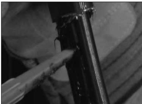
7. Нанесите силиконовый герметик между отдельными трубками с обеих сторон, чтобы обеспечить надлежащую герметизацию.
