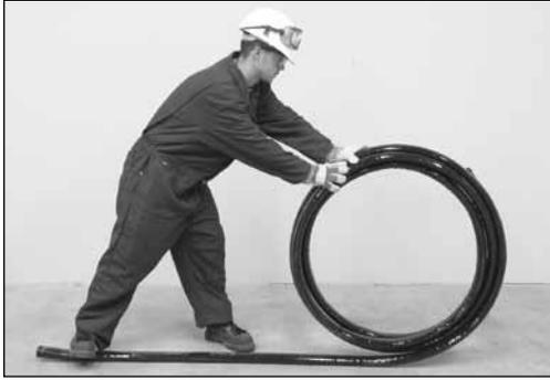
**Метод 2.** С помощью второй, меньшей по размеру катушки распрямляйте изделие по мере его разматывания с большой транспортировочной катушки.
